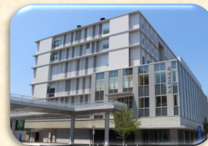
石巻市立病院外観
